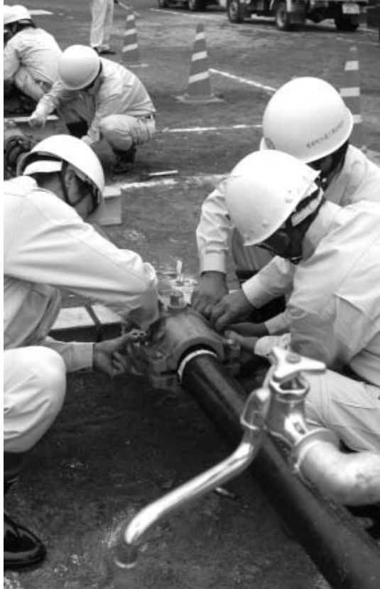
水道施設復旧訓練
