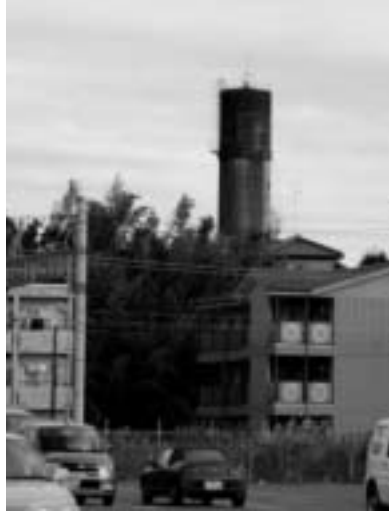
東地区の配水塔
