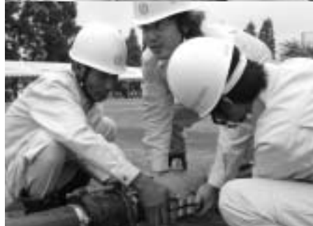
【総合防災訓練】 平成15年9月7日撮影 板倉町水道工事店組合による 水道施設復旧訓練 水道管に生じた亀裂による漏水を処置する
