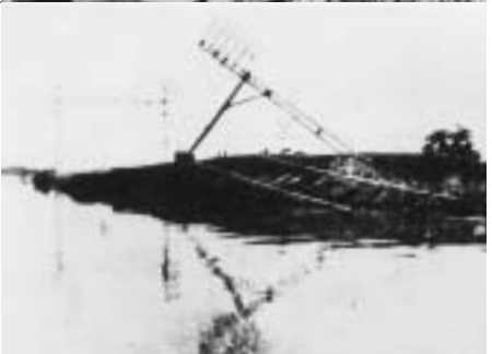
【カスリーン台風】 昭和22年9月18日撮影 旧海老瀬村地内 東武日光線の惨状 (減水 1 m50cm 時)
