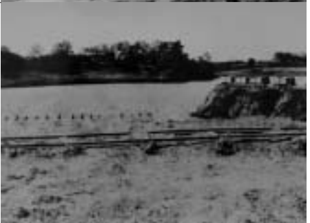
【カスリーン台風】 昭和22年9月撮影 旧海老瀬村地先 渡良瀬川堤防決壊箇所
