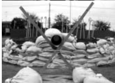
【総合防災訓練】 平成15年9月7日撮影 板倉水防団(板倉消防団)による 月の輪工法実施訓練 *月の輪工法 堤防裏からの漏水を月の輪状に囲った中にたまる水で漏水の圧力を弱める工法。
