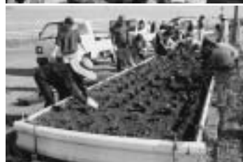
ガードレールを利用 しての植栽です (南地区)
