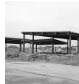
工事も順調! 10月中旬、オープン
