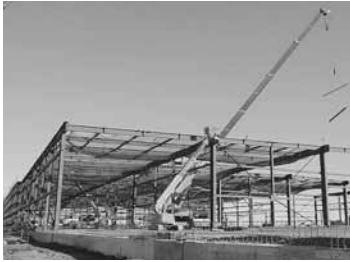
建設工が進む岩田流通団地
