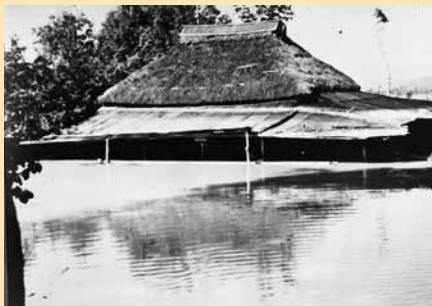
カスリーン台風（西谷田村大字離）
