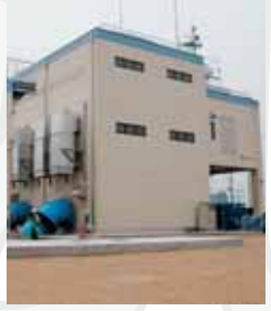
改修が終わった 邑楽東部第2排水機場
