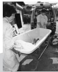
シートを敷いた後浴槽を搬入します
