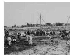
洪水時の堤防工事 古い写真展より
