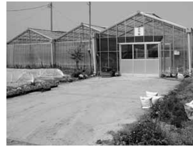
後継者の育成のため 大型温室施設を整備
