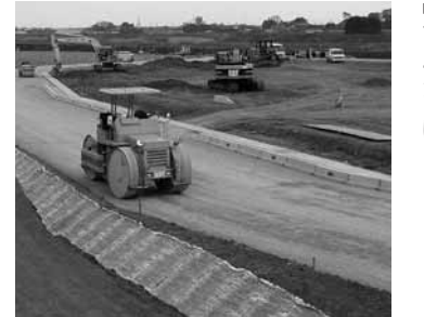
造成中の岩田流通団地
