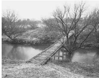
沈下橋は河川や水路が張り巡らされている板倉町内にかつて数多く見られました。しかし現存する沈下橋は谷田川と旧合の川の合流地点にある「通り前橋」と「北坪東橋」の2本のみです。板倉町にある沈下橋の特徴は欄干がないことと木造であるということです。欄干をつくらないうことにより、谷田川の水位が上昇して橋が水面下に没したときに流木や土砂により橋が破壊されたり、川の水がせき止められ洪水になることを防ぐことができます。また万一、橋そのものが流された場合にも比較的安い費用で橋が再建できるというメリットもあります。
