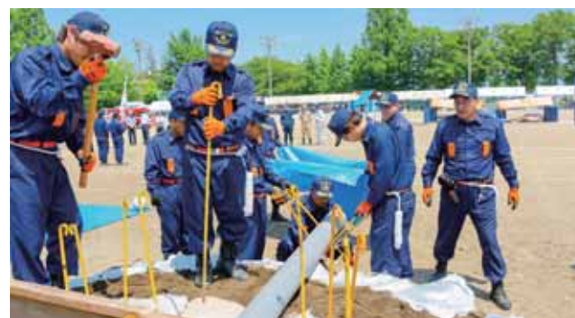
↓水防工法訓練では水防団が力を合わせて月の輪工法を実施
