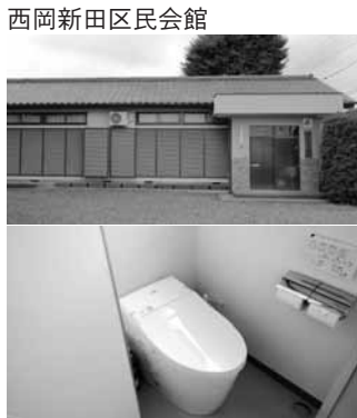
改修したトイレ
