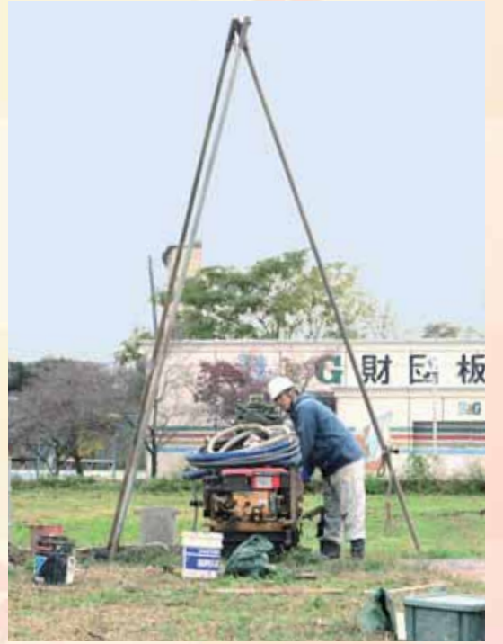
新庁舎建設予定地の地盤調査を行いました
