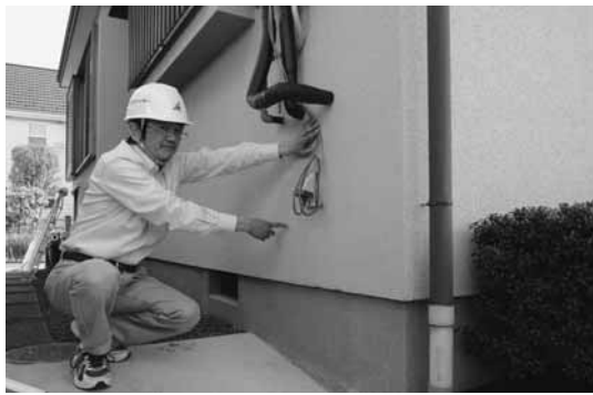
耐震診断では建物の外壁にひび割れがあるか調べます
