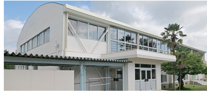
改修工事を行った東小学校体育館
