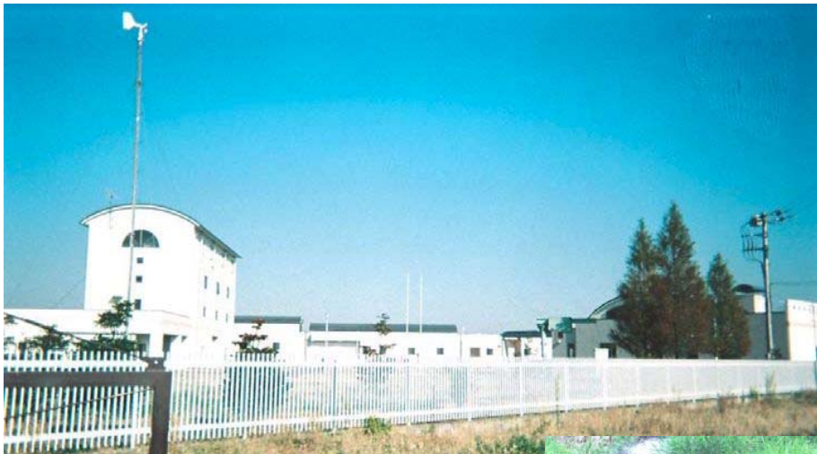
【水質浄化センター】
