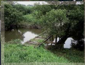
沈下橋（通り前橋）
