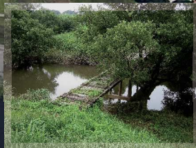
沈下橋（通り前橋）
