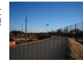
五百間堤 谷田川の左岸堤で、 古河往還の一部です。 江戸時代に造られた 堤防で、長さはほぼ 500間(約900m)です。
