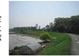
引堤 古河往還の一部です。 天保10年(1839)、決壊 によって改修工事をお こなったことが古文書 によってわかります。
