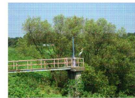
北根樋門 「三ヶ村絵図」によって江 戸時代から、樋門であつた ことがわかります。
