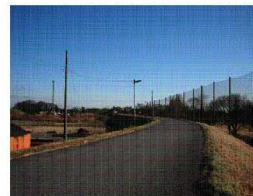
五百間堤 谷田川の左岸堤で、 古河往還の一部です。 江戸時代に造られた 堤防で、長さはほぼ 500間(約900m)です。
