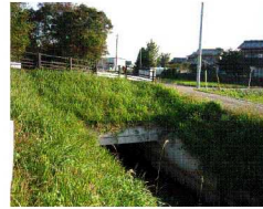
土橋（困堤） 谷田川の逆流を防ぎました。 文禄堤と同時期（約400年前） に造られたと考えられます。
