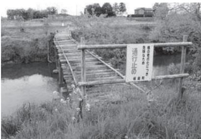
▲橋が曲がり通行止めの沈下橋
